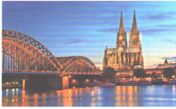
Kölner Dom Baubeginn 1248
